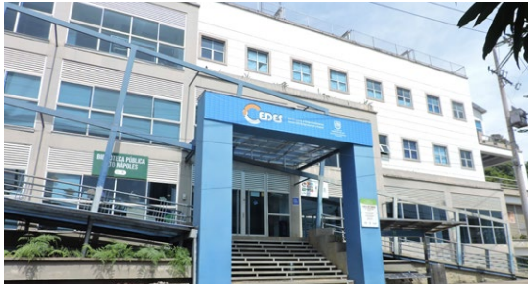
Edificio 'Mi Cali Bella se Integra', ubicado en la Comuna 18.
