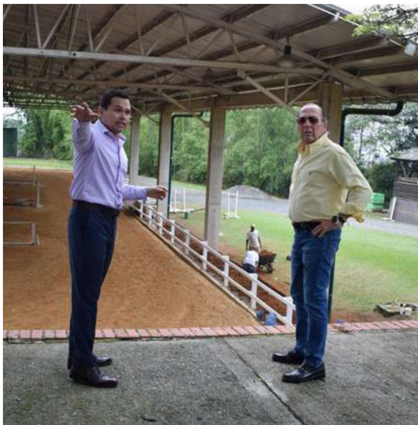
El presidente de la Junta Directiva, Alberto Hadad Lemos, y el gerente del Club, Rolando R. Rojas, inspeccionan las obras ejecutadas en el picadero 2, en el área de Hípica.
