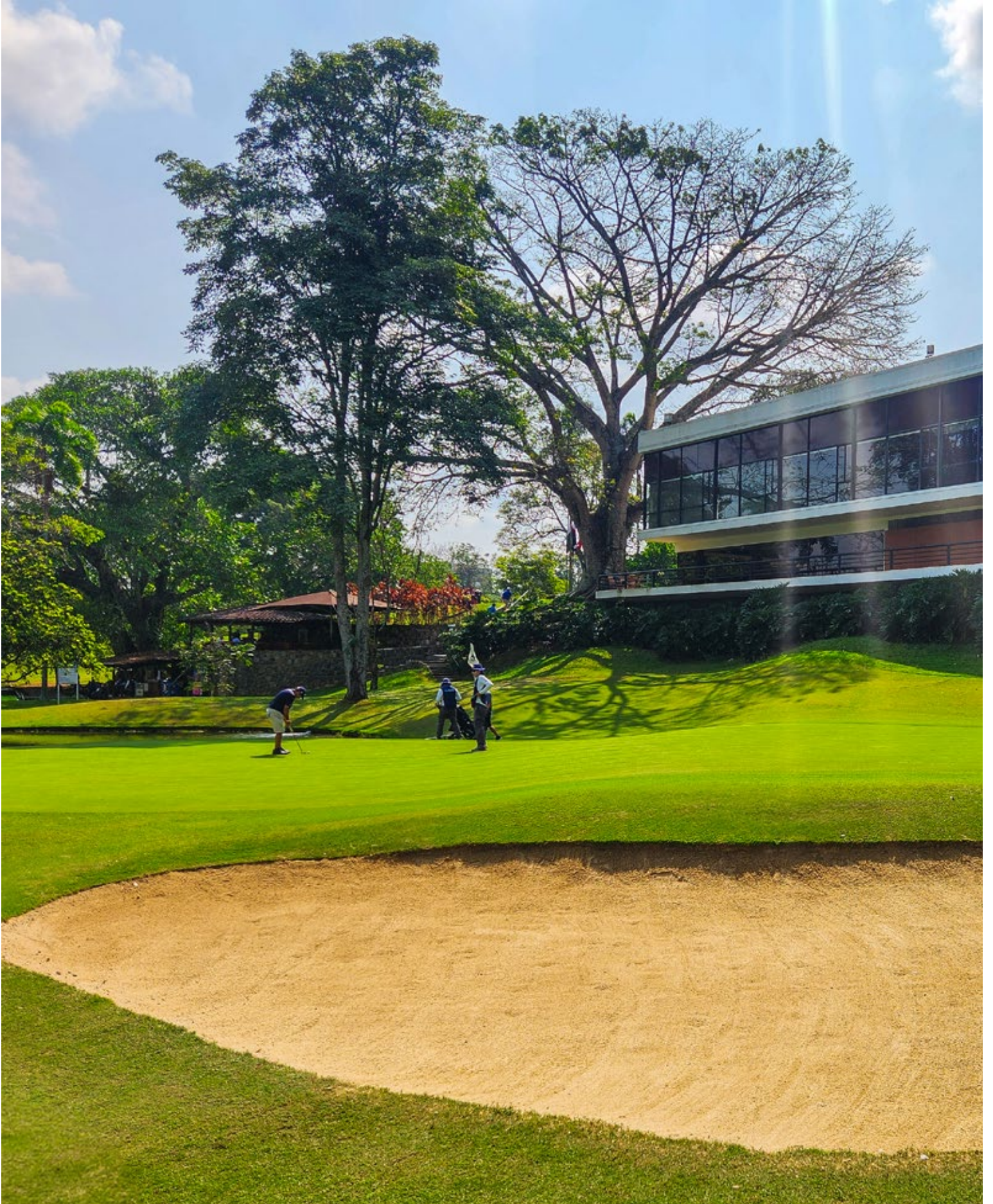
Reconstrucción de búnkers en campo de golf.
