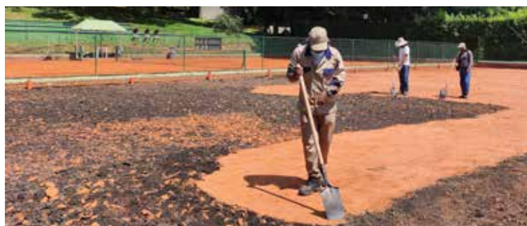
Reparación total de los pisos de las canchas: Tenis Principal 11 y 12, Tenis Coco 21, 22, 24 y 28. Se realizó mantenimiento general, cambio de líneas y desagües en las canchas 5,6,14,16,19,20,30,31.
